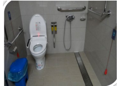
圖一 浴廁加裝扶手
